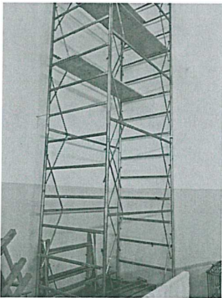
Trabattello ancorato a muro
